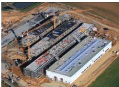
Luftbild des 55.000 m² großen Baufeldes
