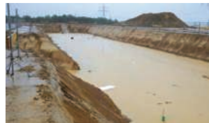
Canal Grande im Baugrubenbereich
