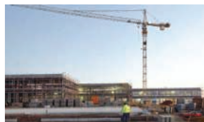
Büro und Laborbereiche Bauteile E, D und B
