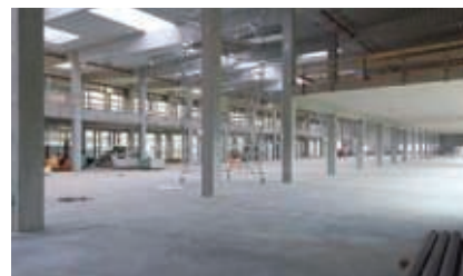
Halle Bauteil A in StB-Fertigteilkonstruktion
