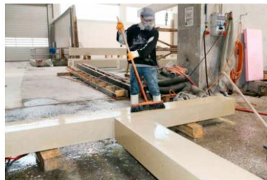
Der Architekturbeton für das Stadtschloss wird mit Ameisensäure behandelt.
