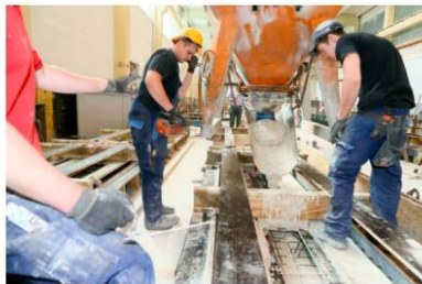
Der Guss: Beton fließt aus dem Kübel in die hölzerne Schalung.
