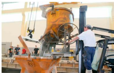
Der Beton wird vorbereitet.
