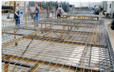
Stählerne Monstren: die Stahlgitter, die den Betonteilen zu einer Erhöhung des Tragverhaltens verhelfen.
