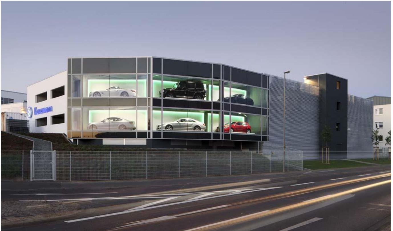
Das Multifunktionsgebäude bietet vom Untergeschoss bis zum Dachgeschoss Platz für ca. 135 PKW's. Für das Reifenlager, das Reststofflager und die Ausstellung wurden ca. 960 m<sup>2</sup> Fläche geschaffen. Die Konstruktion wurde als massive Ortbetonkonstruktion, zum Teil in Sichtbeton, erstellt. Die Ausführung des Rohbaus erfolgte durch die Dreßler Bau GmbH. Die Ausbau- und Fassadenarbeiten wurden durch unseren ARGE-Partner, Fa. Züblin, ausgeführt.
