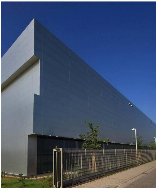
Neubau eines Logistikzentrums zur Lagerung, Kommissionierung und zum Versand von Edelstahl-Küchenzubehör. Das Gebäude besteht aus einer Stahltragkonstruktion mit aufwendiger Alucobond-Fassade und einem in das Gebäude integrierten Bürotrakt. Durch eine künstlerisch gestaltete Beleuchtung des Gebäudes und der Außenanlagen wird das Gebäude nachts zusätzlich hervorgehoben. Das Bauvorhaben wurde schlüsselfertig errichtet.
