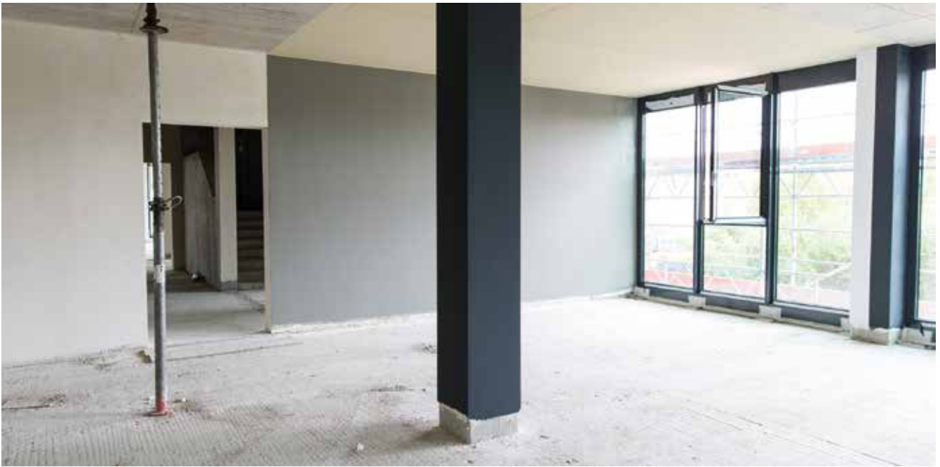
Eines der künftigen Büros in der Despag-Straße. Hier noch im puristischen Beton-Look.
