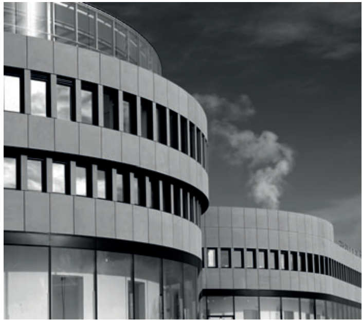
Die Fertigteile der vorgehängten Sichtbetonfassaden schmiegen sich an die geschwungenen Baukörper an.
