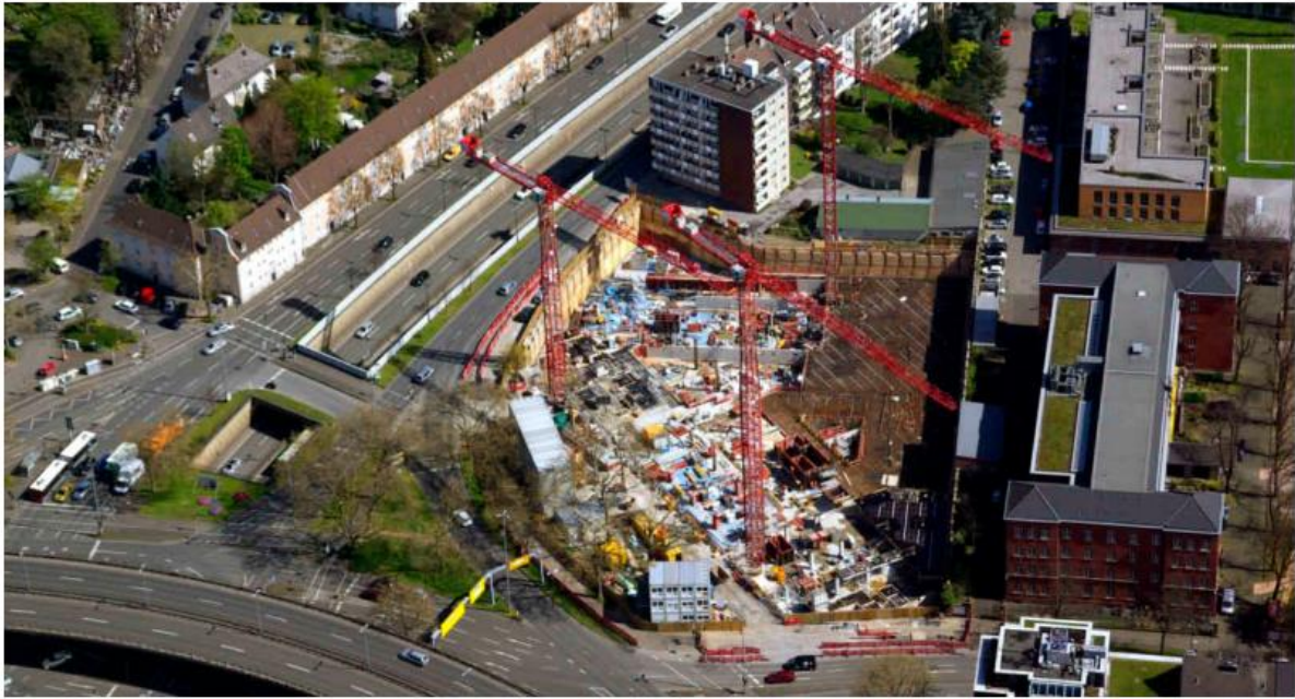
Großprojekt »Horizon«: In Düsseldorf baut die Dreßler GmbH ein 16-stöckiges Bürogebäude. Nach Abschluss will der Kosmetikkonzern L'Oréal einziehen. Foto: Die Developer
