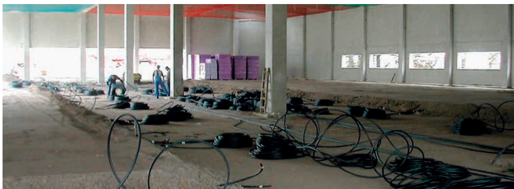
Verlegung der PE-Rohre
