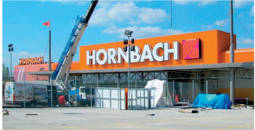
Komplexer Neu- und Umbau während laufendem Marktbetrieb
