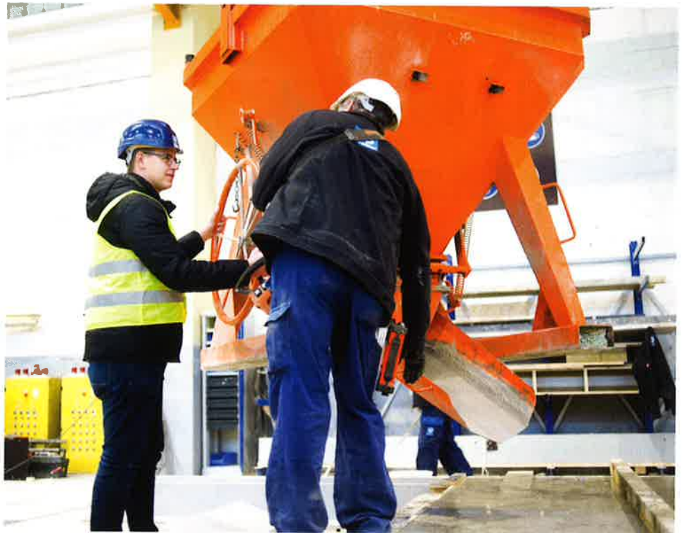
Während der Ausbildung lernen die angehenden Maurer unter anderem betonieren, mit unterschiedlichen Materialien mauern oder Fertigteile montieren.
