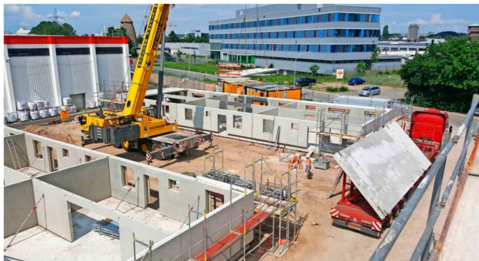
Prototyp für schnelles und preiswertes Bauen: 14 Laubenganghäuser für über 900 Flüchtlinge errichtet die Aschaffener Baufirma Dreßler derzeit am Sensfelderweg in Darmstadt. Fotos: Dreßler Bau GmbH
